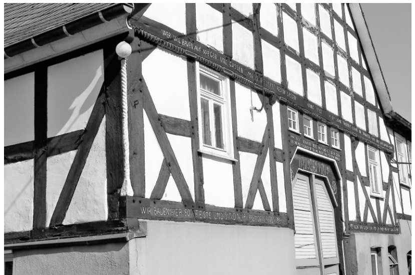
Typisch westfälisch! Das Fachwerk mit Inschriften am Wohnhaus. Links ist der „Geckpfahl“ erkennbar. (wfoto 2022)
