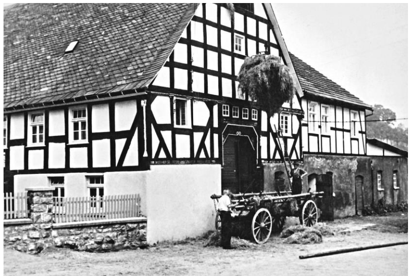
Die Bergung der Heuernte auf dem Dachboden mit dem Heuaufzug.
