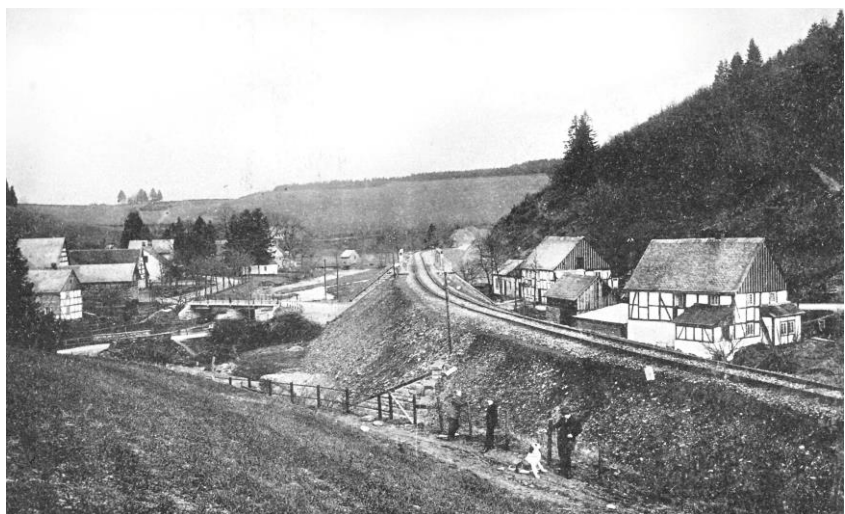
Foto von 1912: Brückenpartie der neuen Bahnstrecke in Frielinghausen. Der neue Bahndamm Richtung Bremke, die Straßenbrücke über die Wenne und im Hintergrund rechts der Gasthof Wiese.
