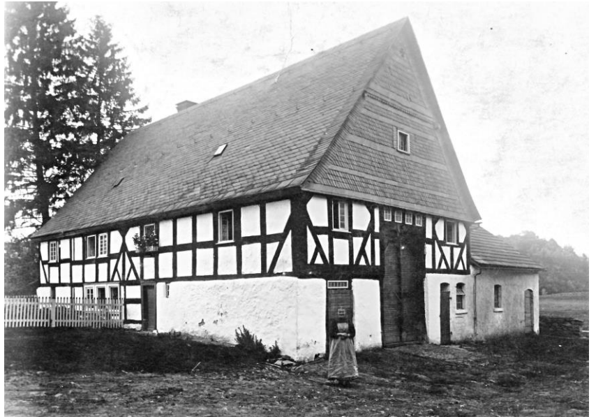
Klöpplers Wohnhaus um 1910, die älteste Aufnahme auf einer Postkarte. Zu dieser Zeit ist der Giebel noch bis über den oberen Querbalken verschiefert. Er wurde erst später freigelegt und machte das Fachwerk und die Inschrift wieder sichtbar.
