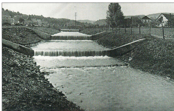
Hochwasserschutz an der Essel, angelegt durch den Reichsarbeitsdienst 1937
