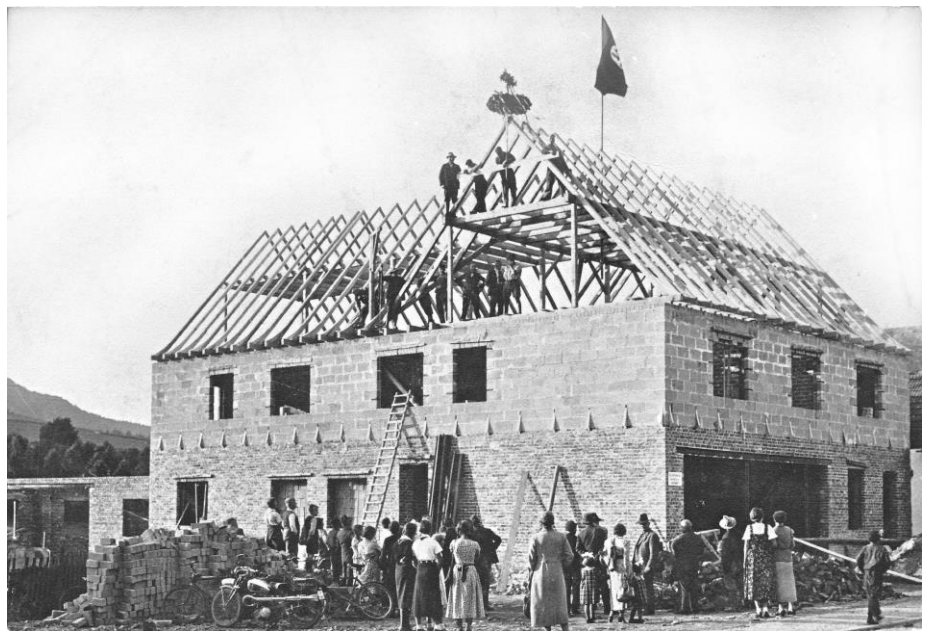
Richtfest 1937 an der Widukindstraße 56 in Eslohe
