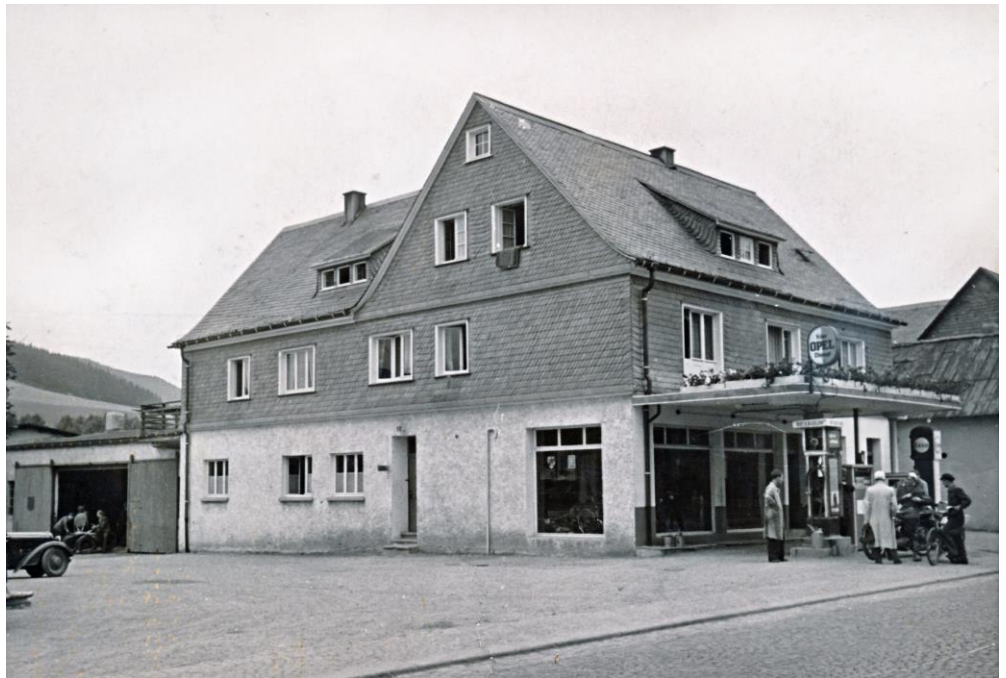
Nach dem Krieg der Neubeginn: Das Haus wurde verputzt, das Geschäft hat ein zusätzliches Fenster erhalten und der Hof wurde befestigt. Die Werkstatt ist 1947 durch einen Anbau vergrößert.
