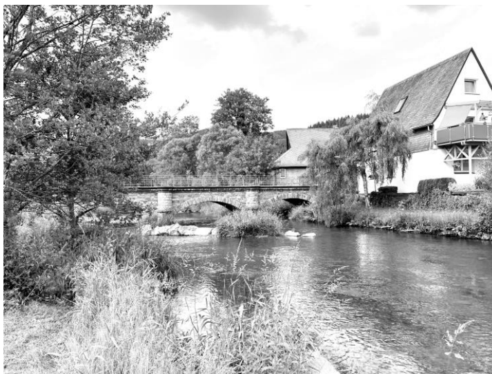
Die Wennebrücke in Wenholthausen, rechts das Hanfranzen Haus (wfoto 2022)
